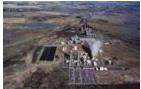
Foto 2 - Termoelétrica de Uruguaiana, RS
