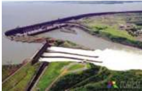
Foto 1 - Usina Hidrelétrica de Itaipu, PR
